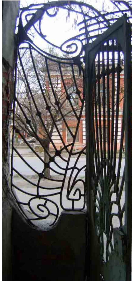
Іл. 5. Металеві двері будинку. м. Харків, вул. Червоножовтнева, 26. Архітектор Л. Любарський. Початок ХХ ст.
