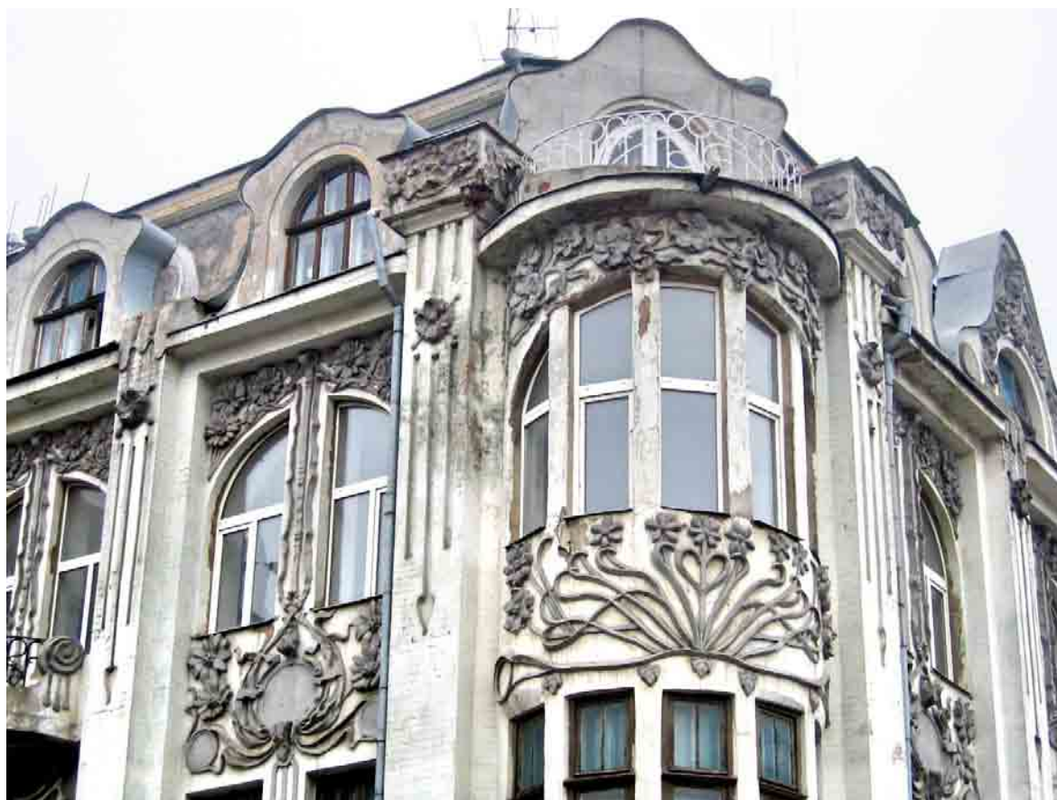
Гл. 2. Ліпний декор на фасадах будинку. м. Харків, вул. Пушкінська, 19. Архітектор О. Гінзбург. 1907 р.
