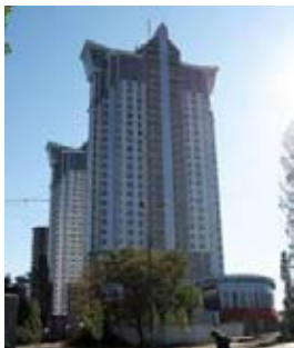
ЖК на розі вул. П. Тичини та Дніпровської набережної
