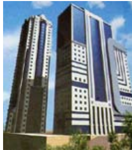
Житловий, офісно-торговий комплекс на вул. А. Барбюса
